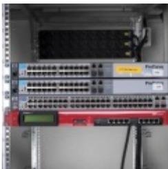
Les armoires Secure-IT Level 3 EMP utilisent des connecteurs protégés pour l'alimentation comme pour la fibre optique. Ceux-ci renforcent l'isolation et les armoires constituent des cages de Faraday protégeant intégralement les équipements
